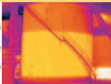
Medida del nivel en depósitos
