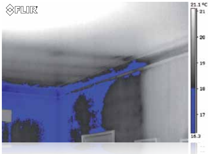
La imagen muestra reflejos en una pared interior (a la derecha) desde la ventana a la izquierda.
